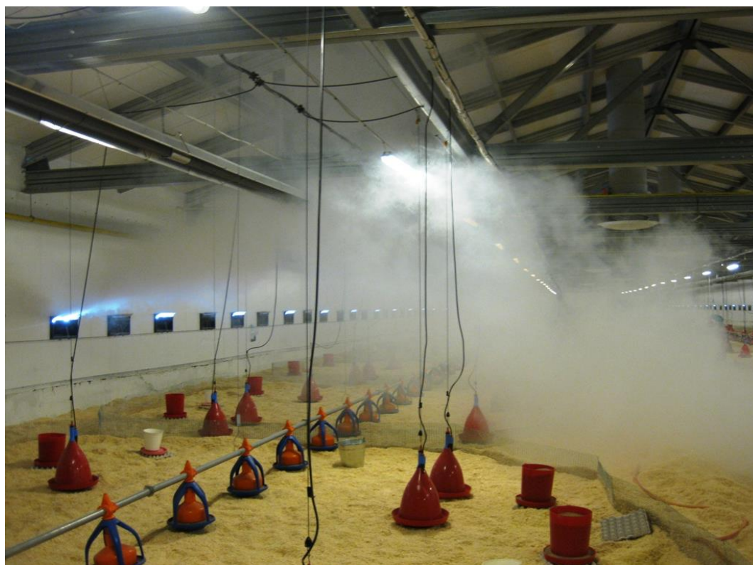
Рисунок 25 – Настройка потока воздуха при помощи дымогенератора
