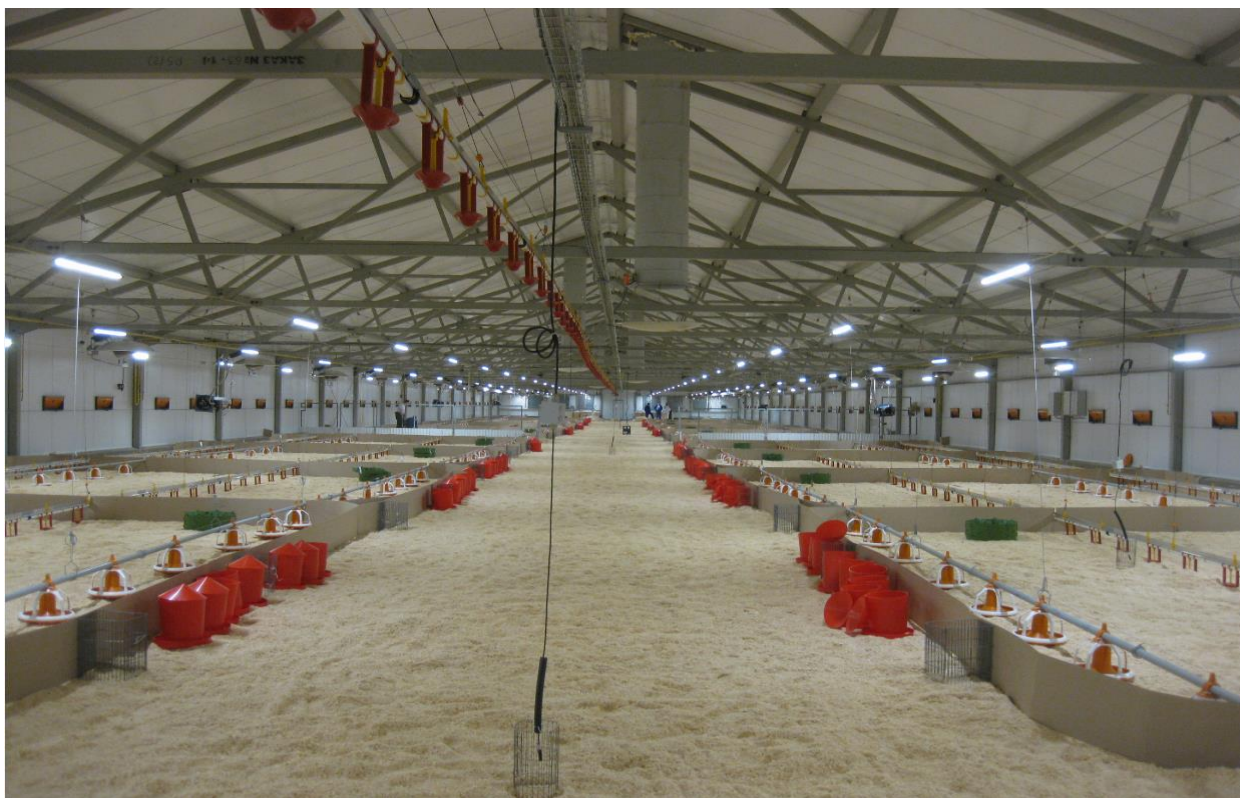
Рисунок 34 – Птичник для подращивания индеек ГК ДАМАТЕ со светодиодными светильниками на высоте 3,0м
